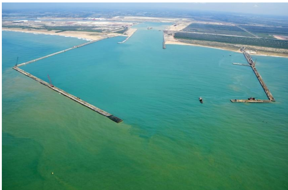
Figura 34: Entrada do canal de navegação mostrando os guias-corrente. Fonte: http://www.skyscrapercity.com/
