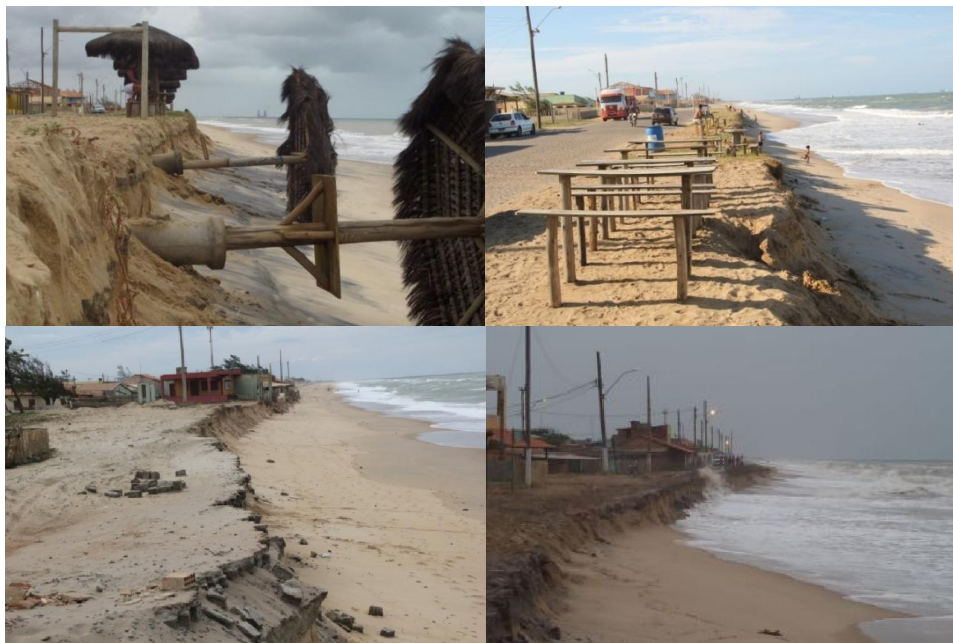
Figura 36: Imagens da Praia do Açú mostrando avanço do mar e erosão da faixa de areia Fonte: SESMA/LEEA/CCH/UENF
