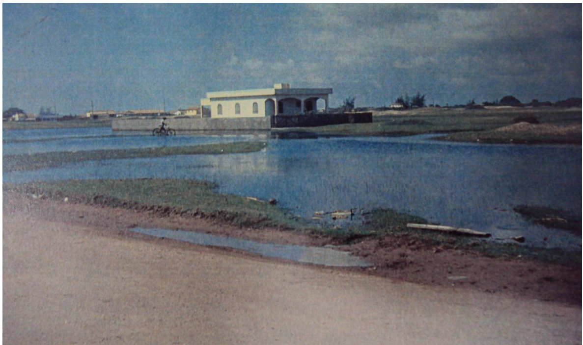
Figura 12 — Residência construída em área alagadiça aterrada.
