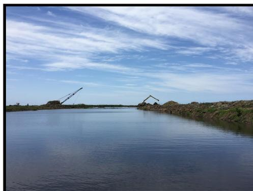
Figuras 15 e 16 - Canal Quitingute: trecho assoreado à esquerda e trecho já limpo à direita, com máquinas ao fundo.
