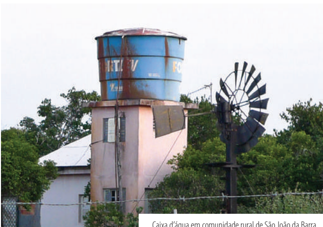
Caixa d'água em comunidade rural de São João da Barra
