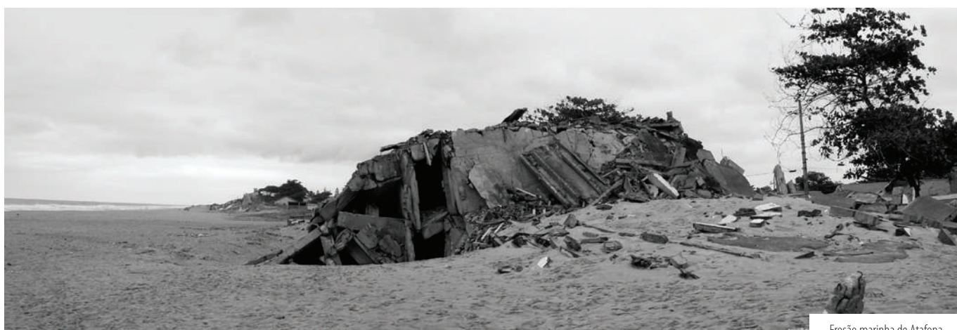
Erosão marinha de Atafona
