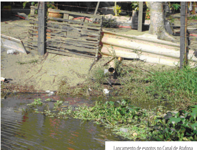
Lançamento de esgotos no Canal de Atafona
