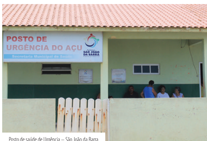
Posto de saúde de Urgência – São João da Barra
