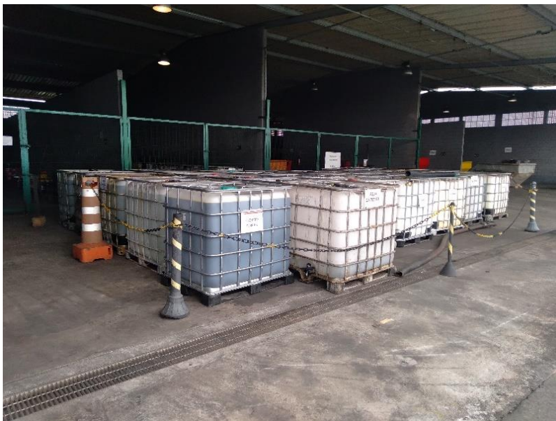
Figura 5.3 – Área de Armazenamento de Produtos Químicos do T-MULT
