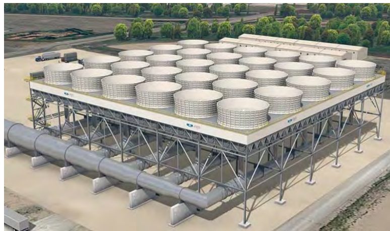
Figura 7.3.3-8 Aerocondensador
