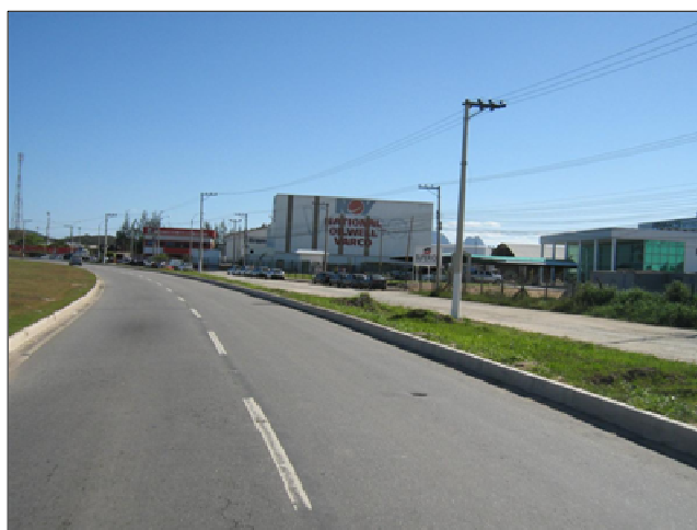
Complexo Industrial de Macaé.
