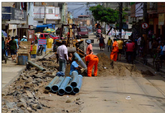
Obras de Rede de abastecimento de água na cidade de Macaé.
