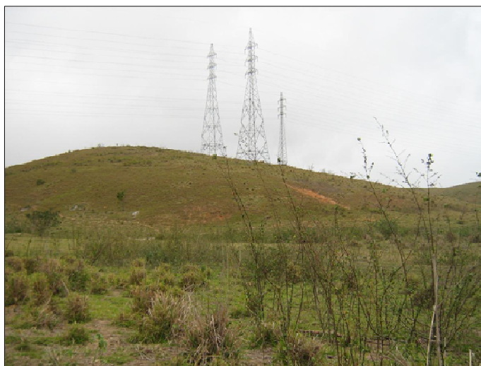
Linhas de Transmissão existentes na área de intervenção.
