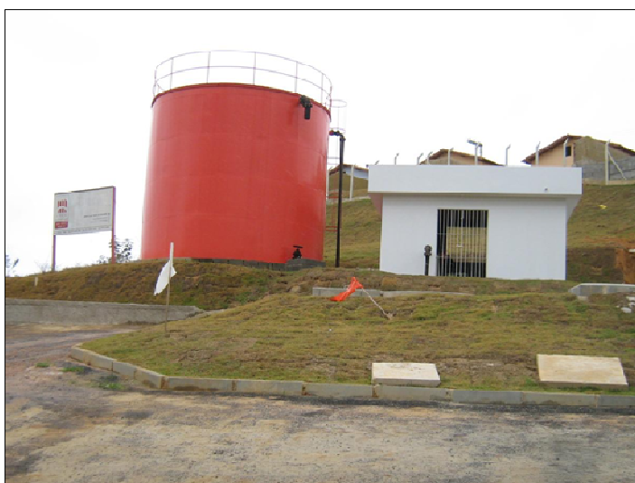
Infra-estrutura de abastecimento de Água do Condomínio Village da Serra.
