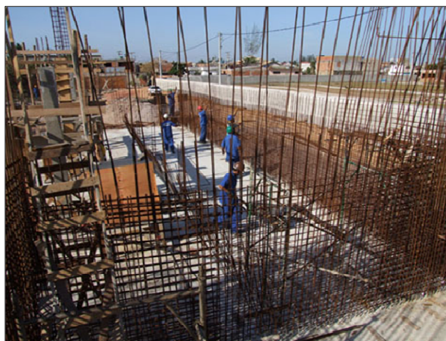
Obras de Estação de Tratamento de Esgoto.
