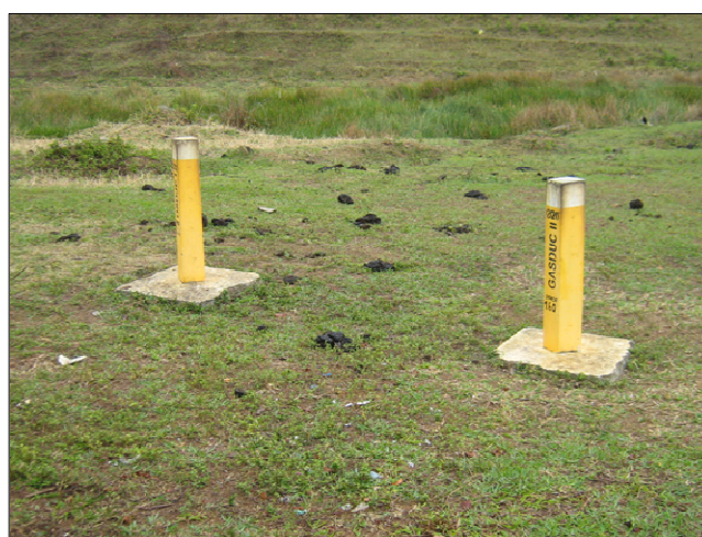
Gasoduto Gasduc – Petrobras
