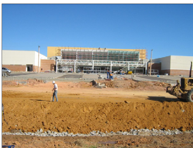
Shopping Center em construção.
